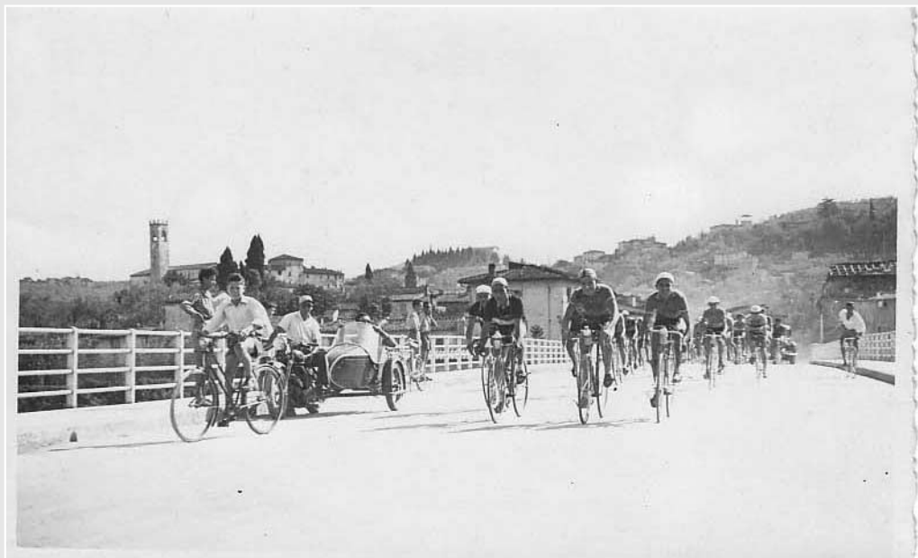
Passaggio di corsa ciclistica sul ponte nuovo
